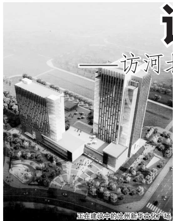
正在建设中的沧州新华文化广场
